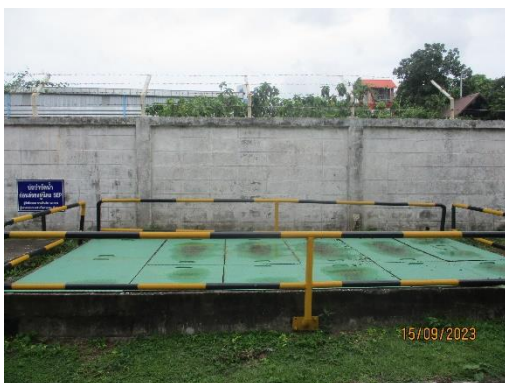
รูปที่ 9 บ่อตรวจสอบคุณภาพน้ำทิ้งที่ 1 (Inspection Manhole No. 1)
